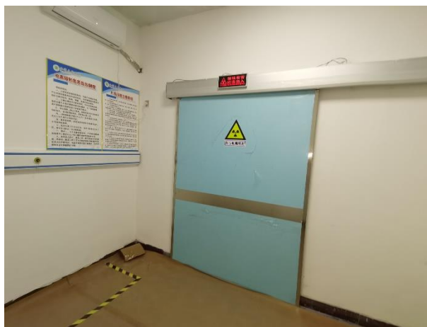
图 3-2 DSA 机房门电离辐射警示标志、工作指示灯及候诊区注意事项告知栏
