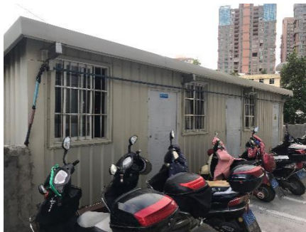
图 2-3 医技大楼东南侧危废间及污泥处理间
