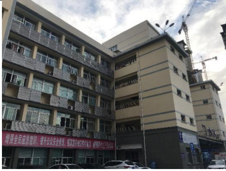
图 2-5 医技大楼西侧门诊楼
