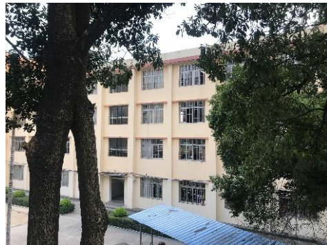
图 2-2 医技大楼东侧仙游县实验小学教学楼
