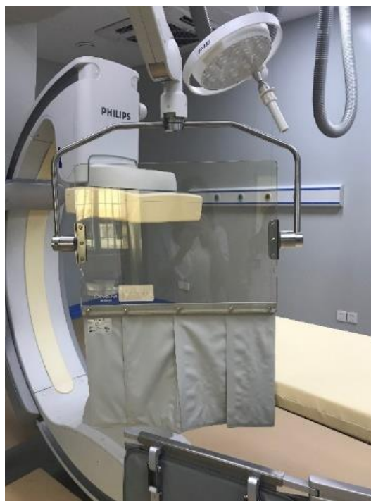
图 2-19 本项目 DSA 现场安装图
