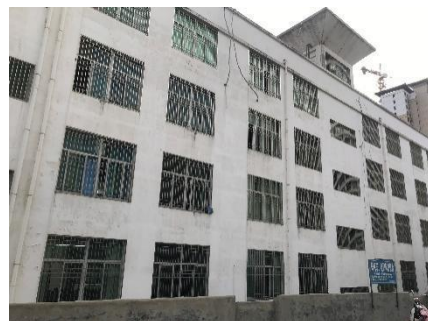
图 2-4 医技大楼南侧仙游县实验小学
