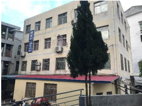
图 2-7 医技大楼东北侧康复楼
